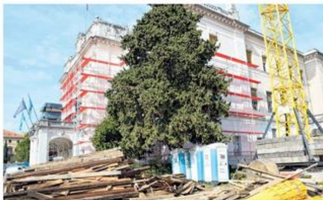
Radovi na Guvernerovoj palači provode se prema rasporedu
